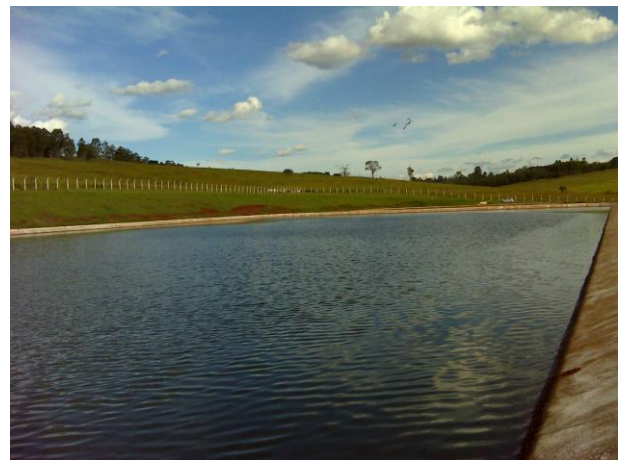
FOTO 6.4 – LAGOA FACULTATIVA DA ETE NORTE
