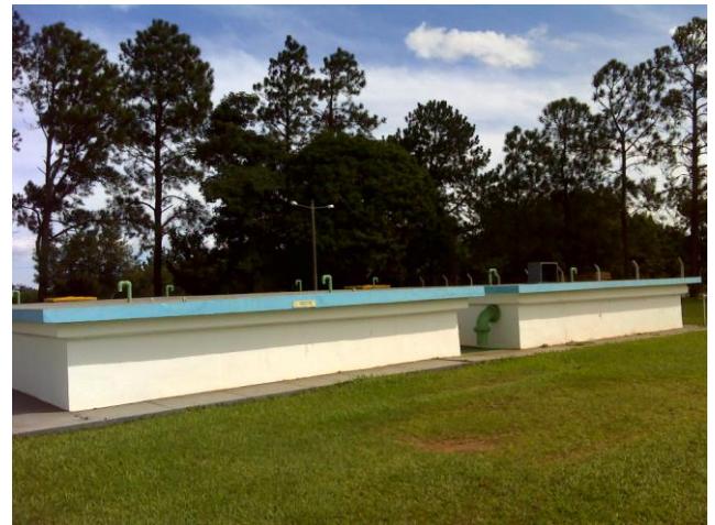
FOTO 5.4 – RESERVATÓRIOS SEMI-ENTERRADOS R1 E R2
