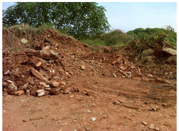
FOTO 7.6 - ÁREA DE DEPOSIÇÃO DOS RESÍDUOS INERTES
