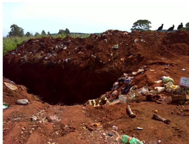
FOTO 7.2 – VALA ABERTA NO ATERRO DE BERNARDINO DE CAMPOS
