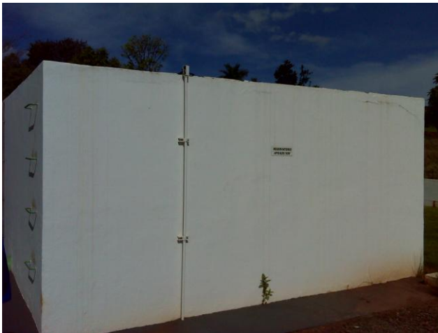
FOTO 5.3 – RESERVATÓRIO APOIADO R5
