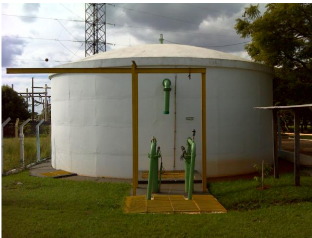
FOTO 5.5 – RESERVATÓRIO APOIADO R4
