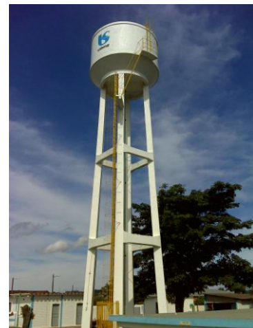
FOTO 5.6 – RESERVATÓRIO ELEVADO T1
