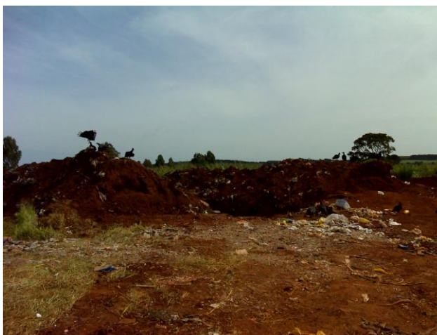
FOTO 7.1 – VISTA DO ATERRO DE BERNARDINO DE CAMPOS
