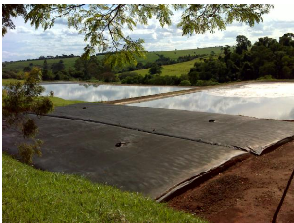
FOTO 6.5 – VISTA DAS LAGOAS ANAERÓBIA E FACULTATIVA DA ETE SUL E DOS BAGS DE ARMAZENAMENTO DO LODO
