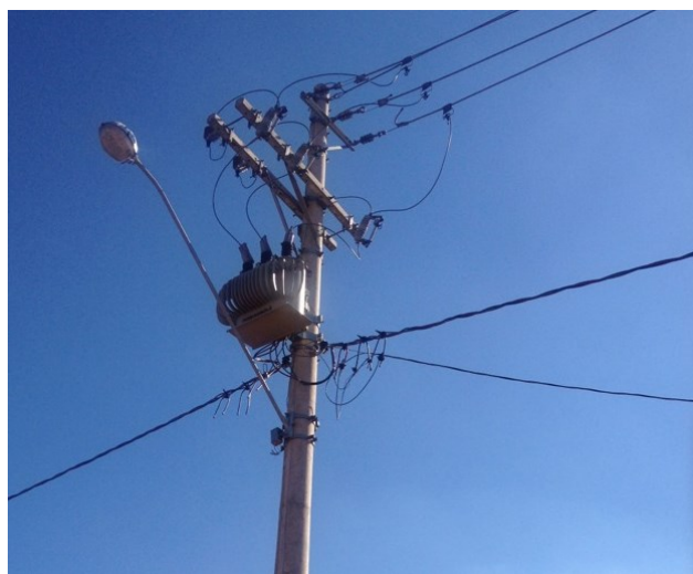
Figura 4— Aproximação do transformador de energia na Av. Guilherme de Arruda Castanho
