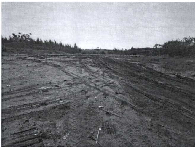
Foto 2: área de aterro de resíduos
