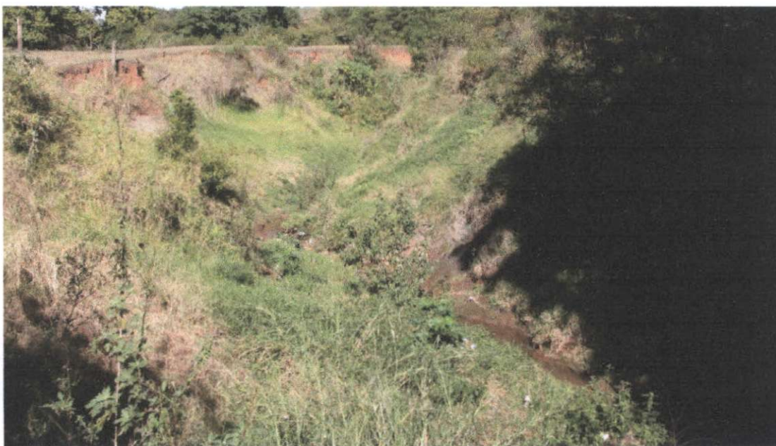
Figura 16: Aspécto geral do córrego.
