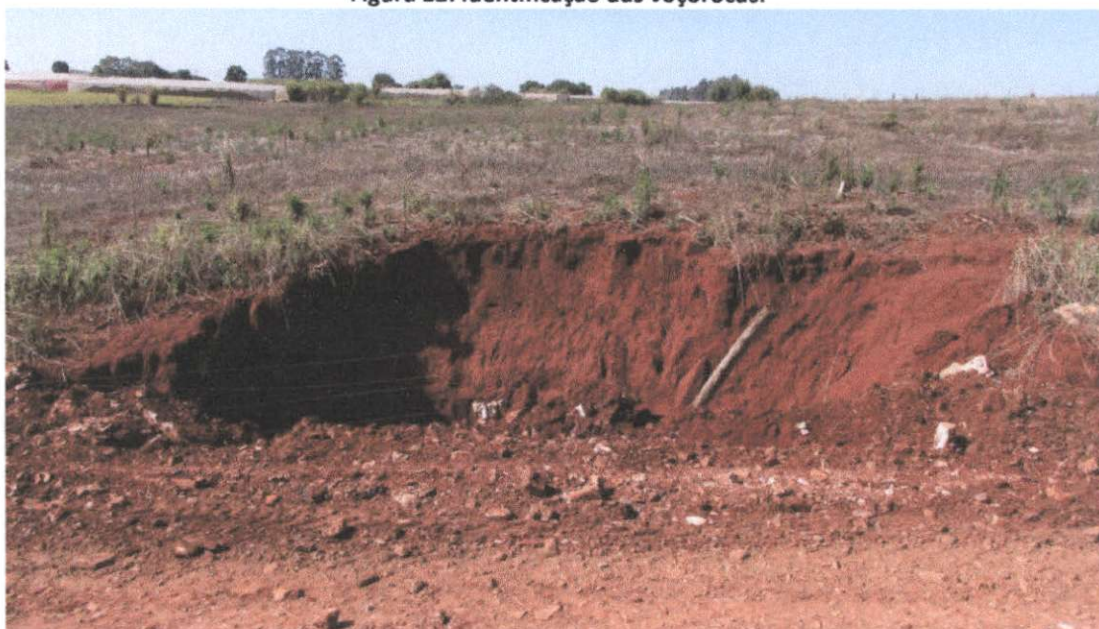
Figura 13: Detalhe da voçoroca 1.
